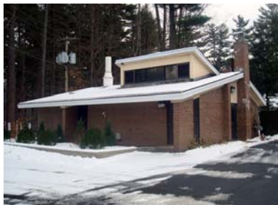
Avloppsvattenstationen vid Lake George
