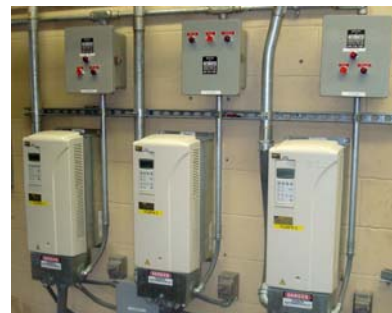
Varje pumpstation är försedd med en Flygt PS200 för att bättre kunna hantera erforderlig pumpkapacitet och ge fullgott pumpskydd.
